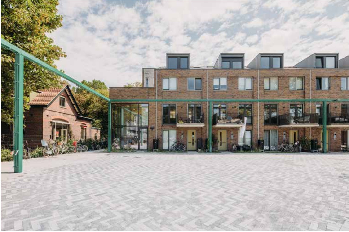
gebouwentree en toegang tot collectieve binnentuin
