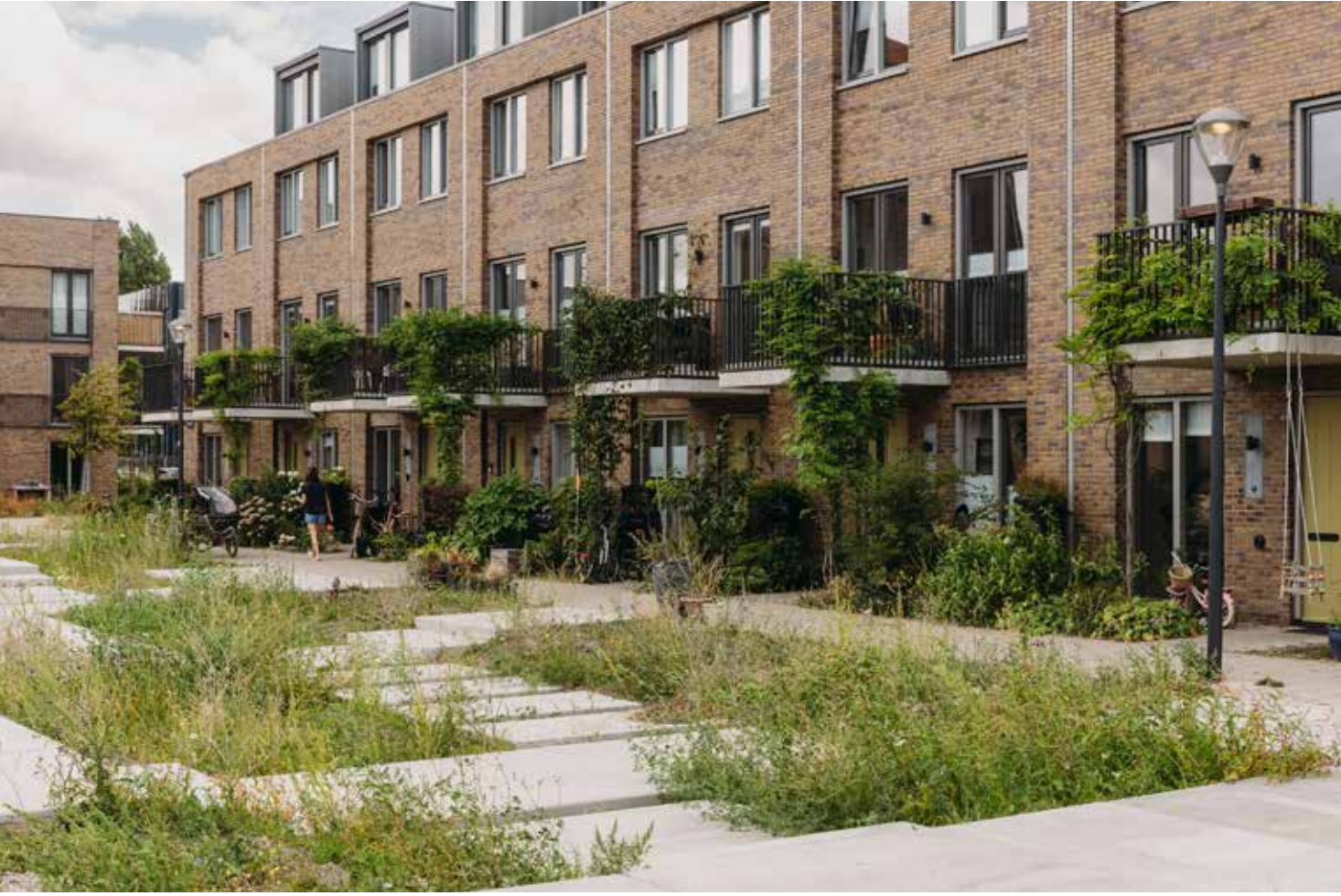
woningen met margestrook aan waterspeelplein
